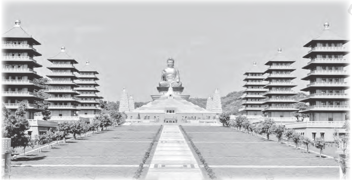
佛館本館近景
