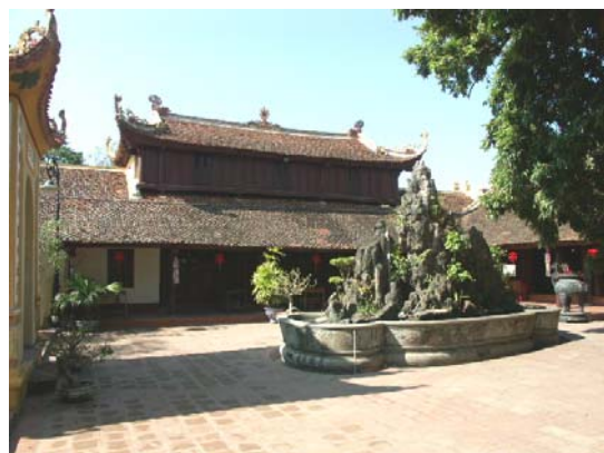
照片-1 鎮國寺鐘樓與祖堂 L 配置圍塑之中庭 (2004/12/21)
