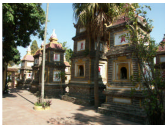
照片 2-鎮國寺入口進來的寶塔區 資料來源：黃蘭翔 拍攝 (2004/12/21)
