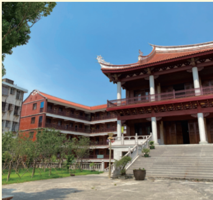
◎ 崇福寺新建的齋堂及僧舍（照片提供：釋見錄）
