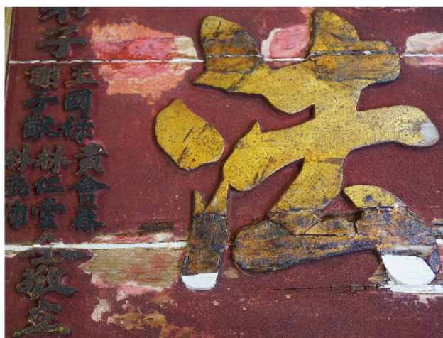
圖4 製作填料填補開裂間隙。
