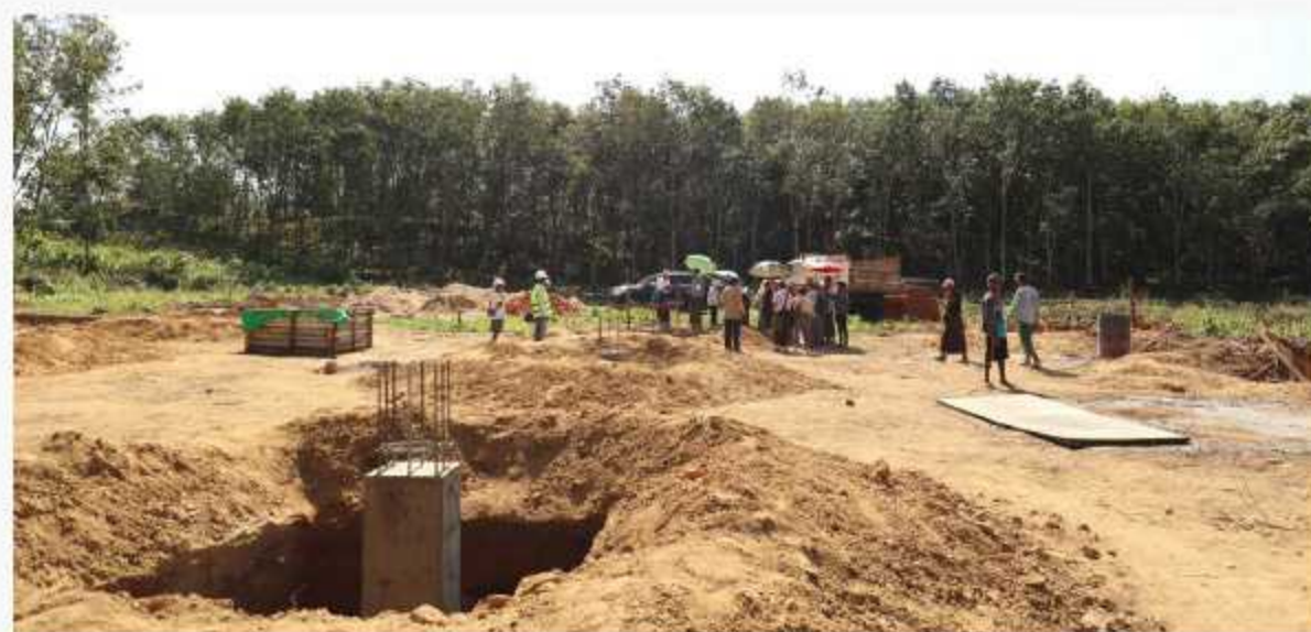
土壤改良設施工程進展
