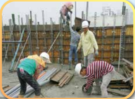
▲屋頂女兒牆及梯澆混凝土
