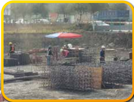
▲ 正德醫院工程擋土牆施工之鋼筋籠綁紮
