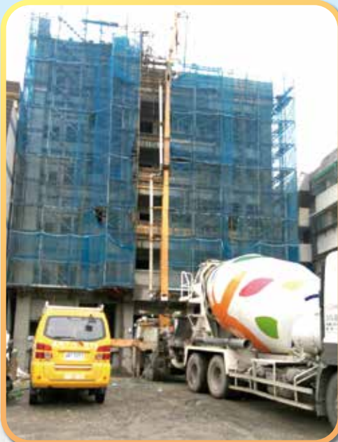
▲屋頂女兒牆及梯澆混凝土
