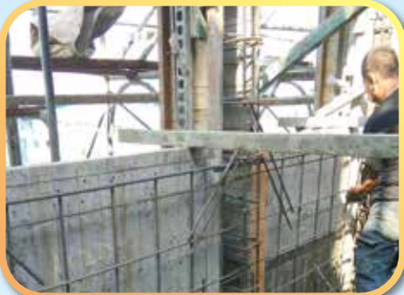
▲梯間牆壁鋼筋綁紮
