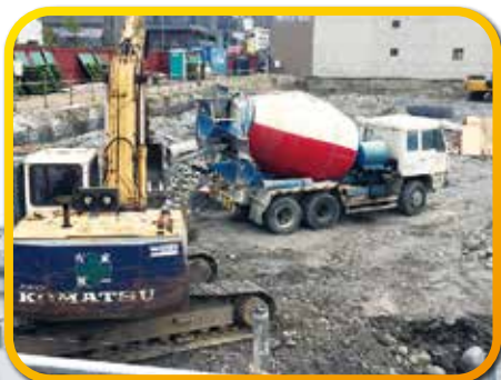
▲ 正德醫院工程擋土牆施工之灌漿及 ▼ 鋼筋籠綁紮工程
