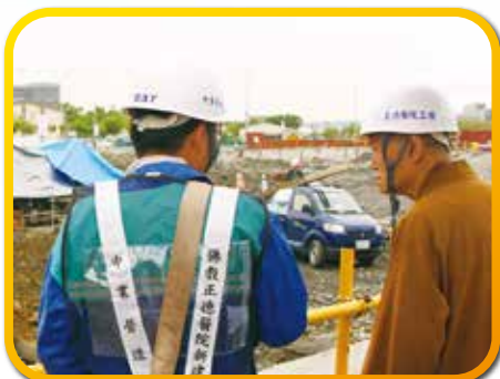
▲ 4/27 開山和尚巡視醫院工程進度
