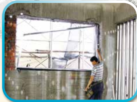
▲窗戶框架施工
