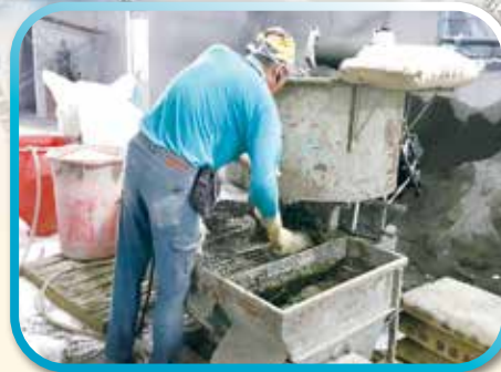
▲樓層輕隔間灌漿
