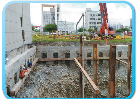
▲ 第一層安全支撐-圍令施工
