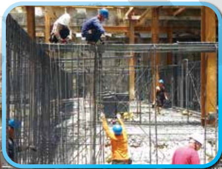
▲ 地樑鋼筋綁紮
