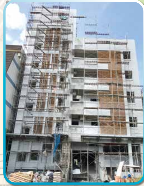
▲ 前面外觀及外牆打底
