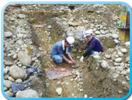
▲ 接地銅板施作
