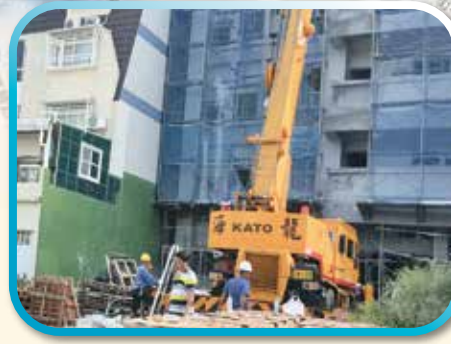
▲ 拆RF露台及四樓露台鷹架
