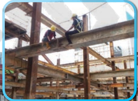
▲ 第二層水平支撐拆除 ▼ B2F 內牆鋼筋綁紮組模
