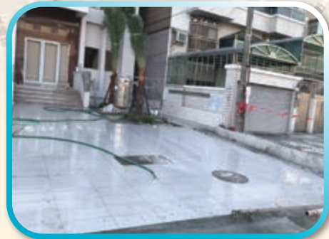
▲ 拋空石英磚地面施作完成
