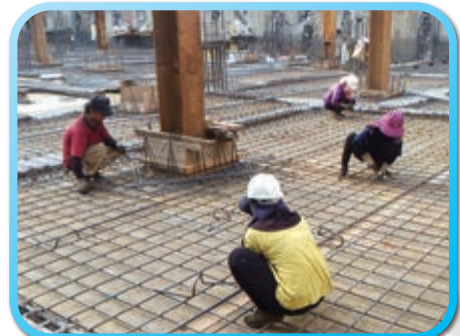
▲ B2F 版鋼筋綁紮
