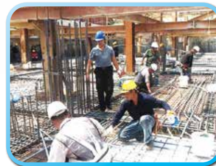
▲ B2F水電管路預埋
