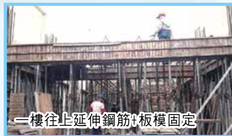
一樓上層綁鋼筋+水電配管線
