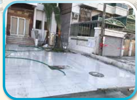
▲ 拋空石英磚地面施作完成
