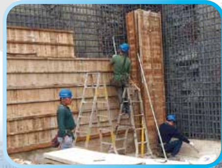
▲ B1F外牆鋼筋組模
