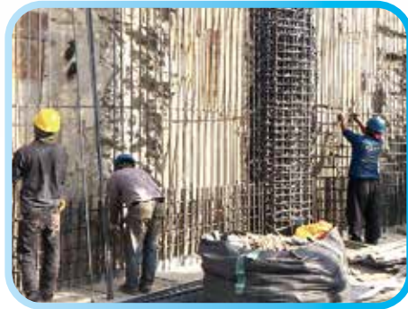
▲ B1F外牆鋼筋綁紮
