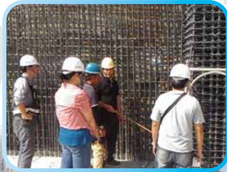
▲ 結構技師查驗鋼筋
