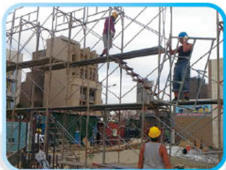
▲ 搭設施工鷹架
