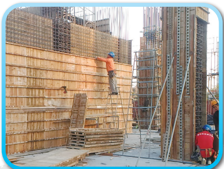
▲ 1樓柱牆模板組立
