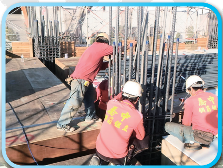
▲ 柱子鋼筋偏移調整
