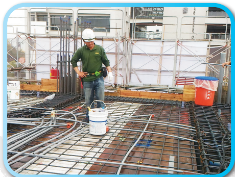
▲ 1樓水電管路預埋
