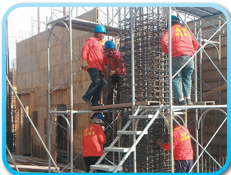
▲ 三樓柱筋綁紮
