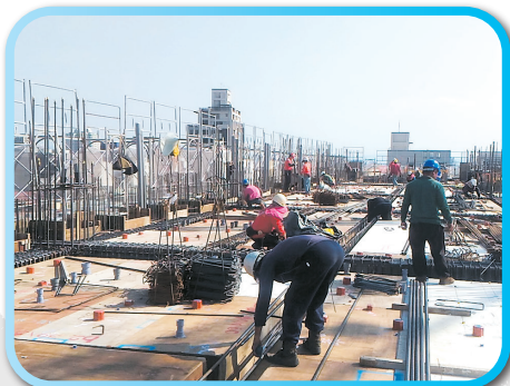
▲ 三樓樑筋綁紮
