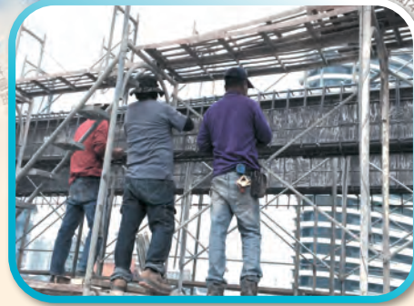
▲4樓外露樑紮筋
