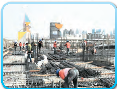
▲ 4樓頂板鋼筋綁紮
