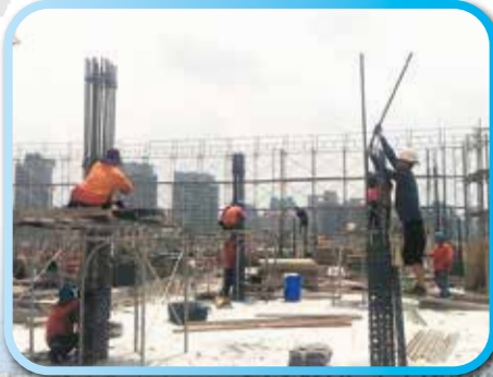
▲ 6樓柱筋組立綁紮
