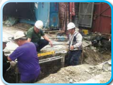
▲ 自來水管路施工
