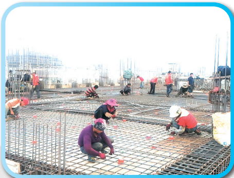
▲ 7樓頂版鋼筋綁紮
