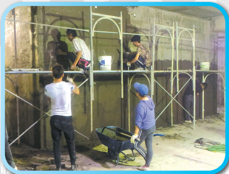
▲ 地下室一樓牆面打底 ▼ 8樓柱牆
