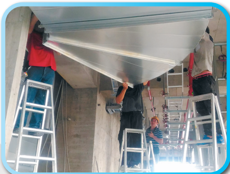
▲ 3樓排煙管施作
