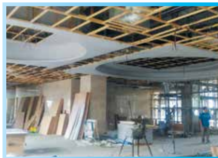
▲ 1F大廳天花板施工
