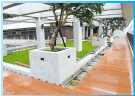
▲ 6F露台木棧道施工
