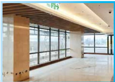
▲ 6F室內裝潢完工 ▼ 行政大樓B1F柱牆施作
