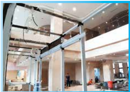
▲ 1F大廳挑空石材施工
