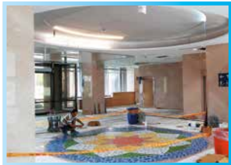
▲ 1F大廳挑空石材施工
