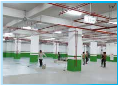
▲ 地下二樓地坪epoxy resin(環氧樹脂)施作
