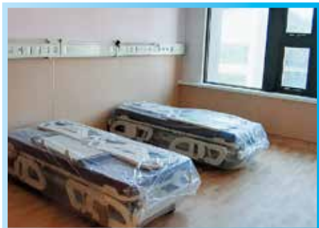
▲病房病床進場 ▼行政大樓3樓施工
