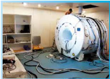
▲MRI 檢查室施作
