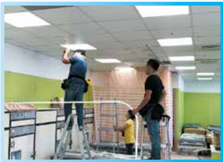
▲洗腎室隔簾安裝
