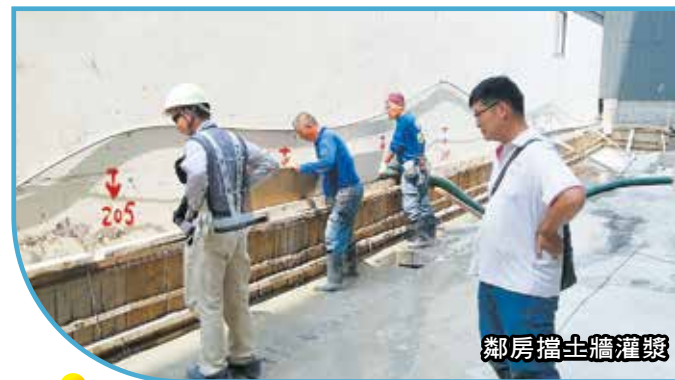
地下室樑版平頂油漆
