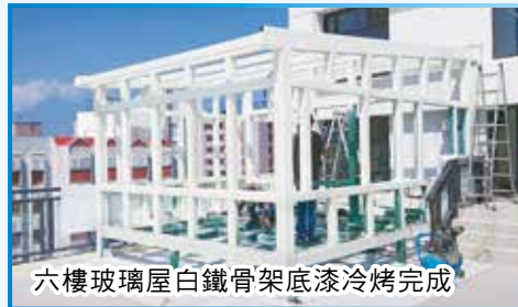
六樓玻璃屋-白鐵骨架組立焊接
