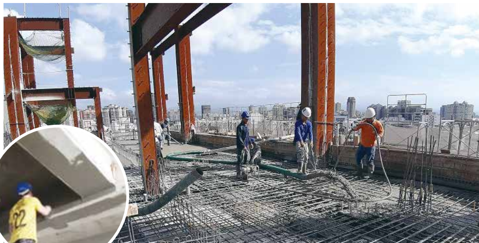
▲地下室頂板研磨批土
