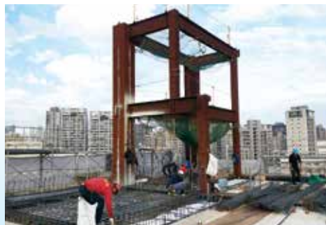
▲R1F樓板鋼筋綁
