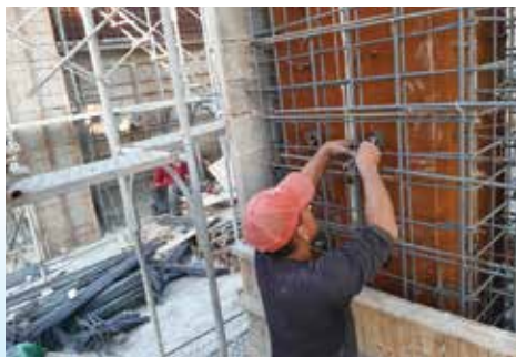
▲R1F柱封模板
