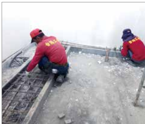
▲ 機房基座鋼筋綁紮
