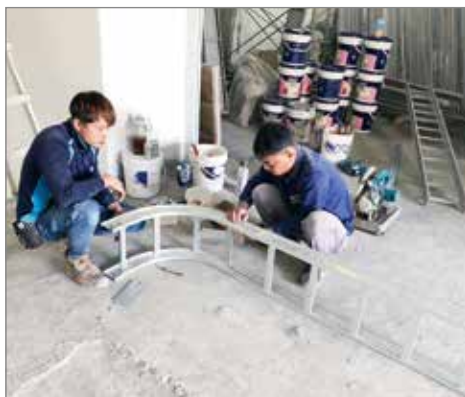
▲ 電線鋁槽施做
