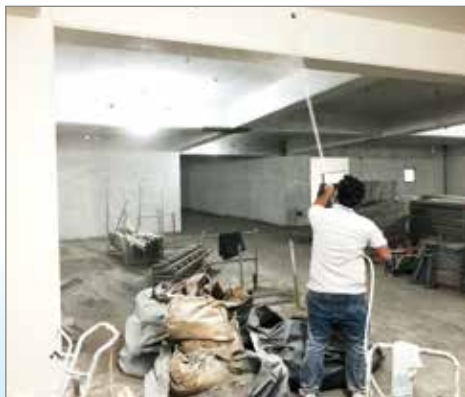
▲ 地下室天花板噴漆
