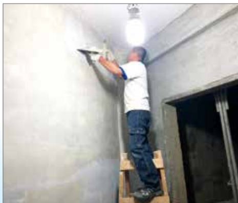
▲ 地下室牆面批白土
