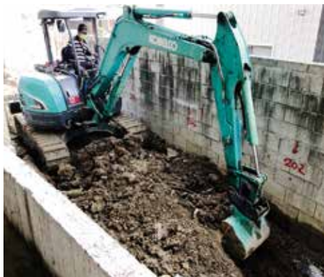
▲西側水溝挖土
