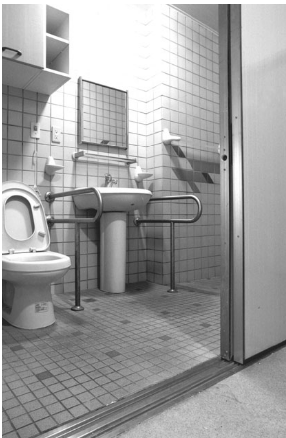
■ 衛浴空間的貼心設計，可以降低老人家在浴室的意外發生：如沒有門檻方便進出，面盆與馬桶高度因應輪椅設計。（攝影／金成財）
