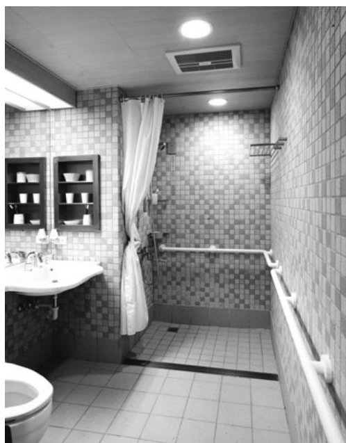
■ 在走道、樓梯、浴室都應設有扶手。
